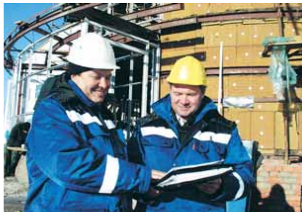
Главный инженер ООО «Энергостройсервис» Виктор Пыжьянов (слева) и директор Наил Загиров на строительной площадке Зауральской ТЭЦ
