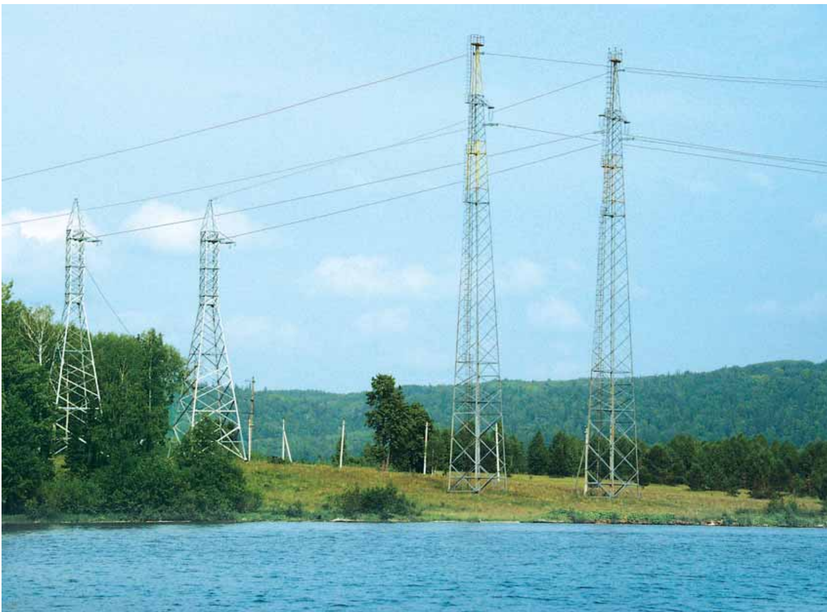
Этот уникальный переход через реку Уфу связал леспромхозы и населенные пункты левобережья с основной энергетической базой республики
