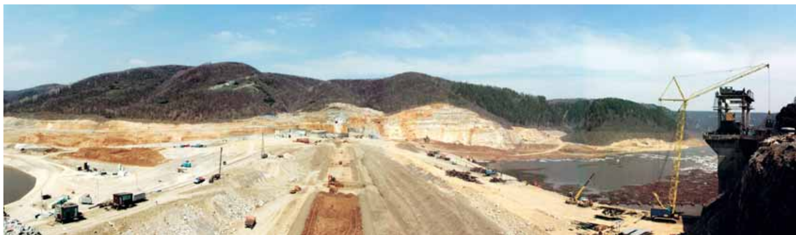
Панорама строительства Юмагузинской ГЭС на реке Белой
