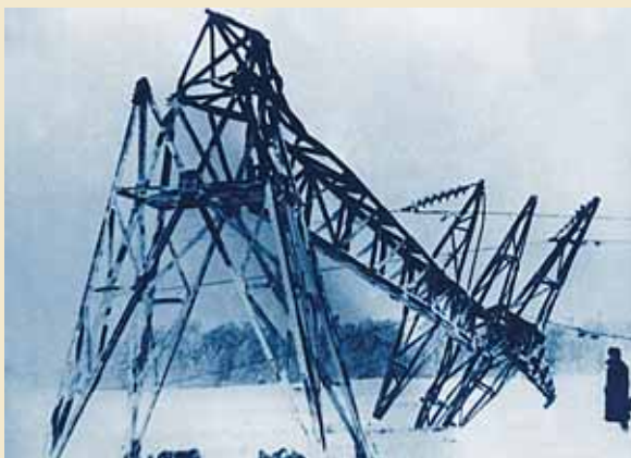
Одна из 12 рухнувших опор на ВЛ-110 кВ «Раевка – Абдулино», 27 декабря 1957 г.
