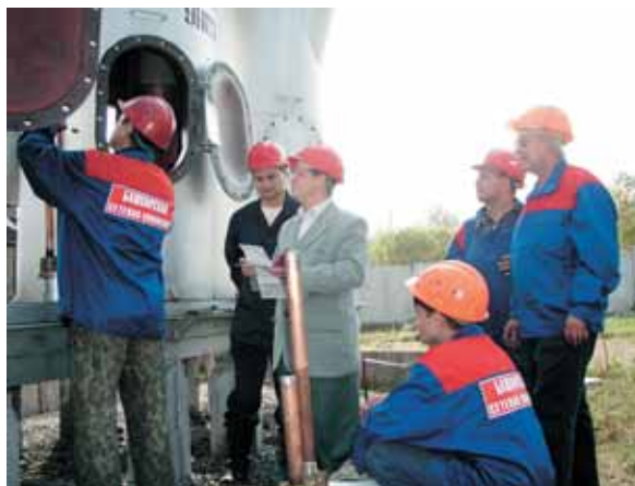
Ремонт выключателя У-110 ведет бригада ПС «НПЗ»
