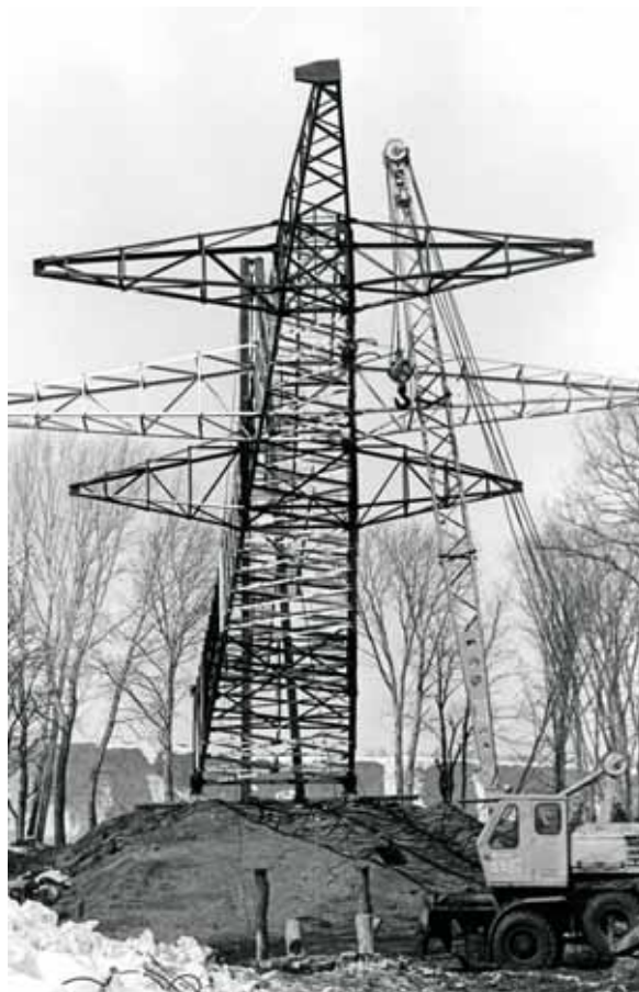
Павловскую ГЭС и ТЭЦ-3 соединила первая в республике ЛЭП-110 кВ
