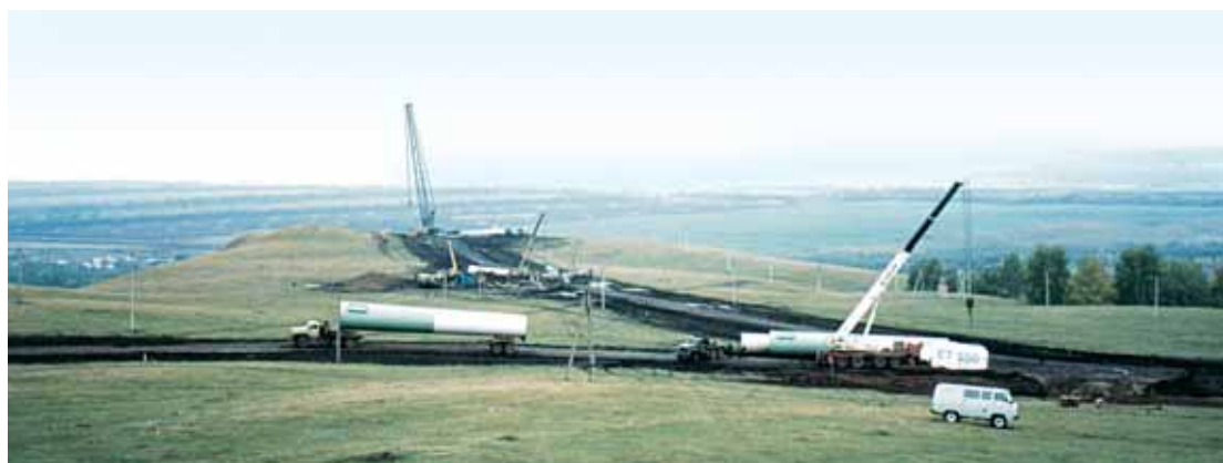
Монтаж ветроэлектростанции «Тюпкильды»
