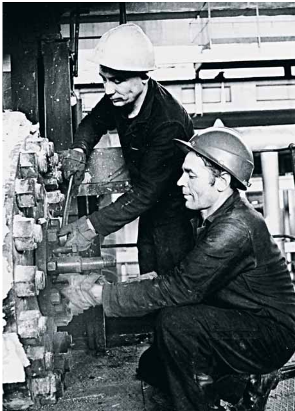
Золотые руки ремонтников – надежный тыл каждой ТЭЦ
