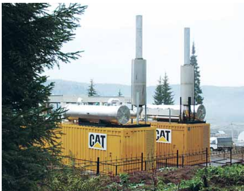
Газопоршневая ТЭЦ в санатории «Ассы»
