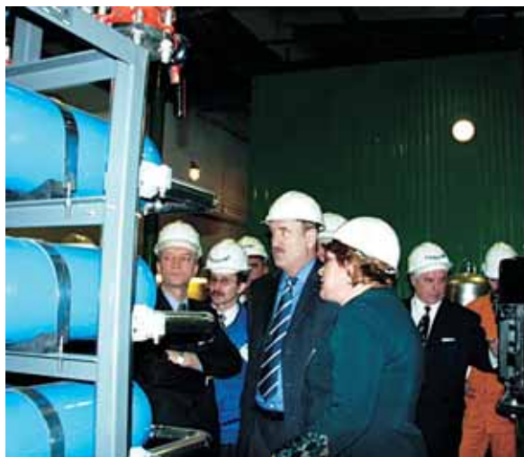
Пуск в эксплуатацию установки обратного осмоса на Уфимской ТЭЦ-1
