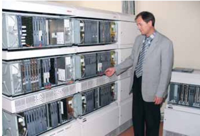
Центральная цифровая АТС «Интеграл 33xE» емкостью 2300 портов связи. Заместитель начальника Центрального узла связи А.Г. Тиммербаев проводит техническое обслуживание
