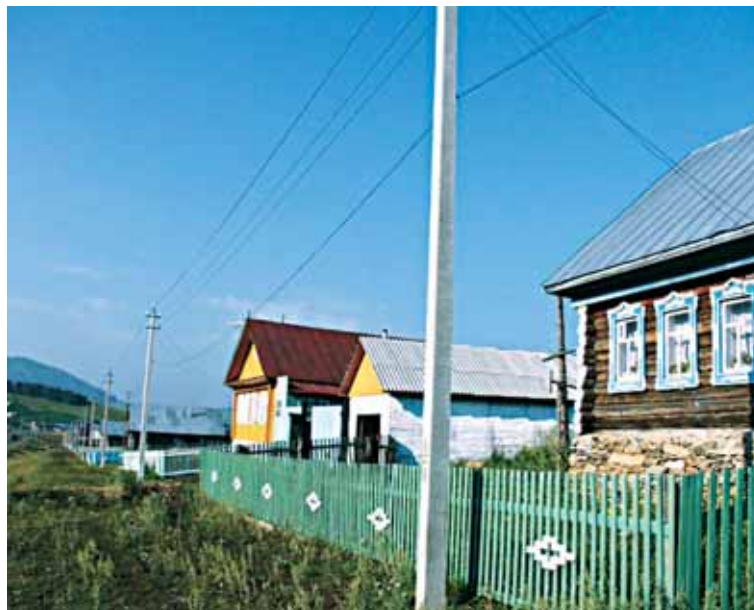
Для сельского населения республики длительные перебои с электроснабжением давно ушли в историю
