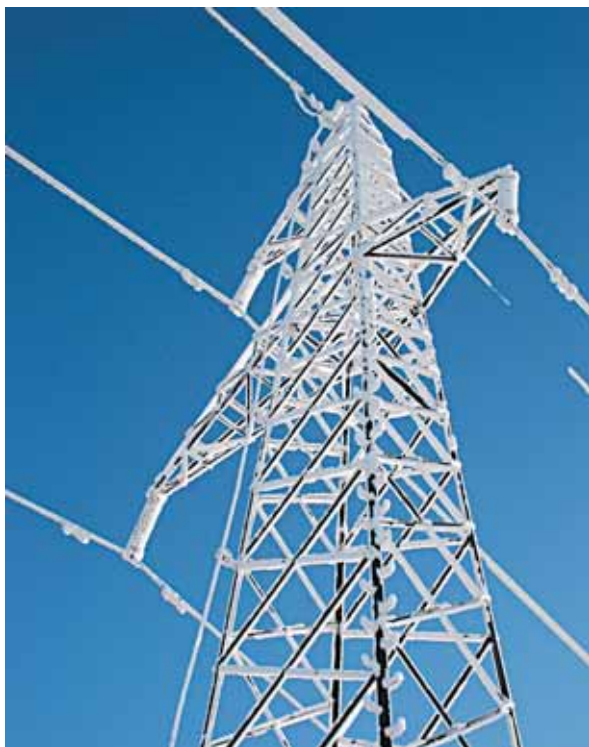
Романтичен, но крайне опасен для опор лед на проводах
