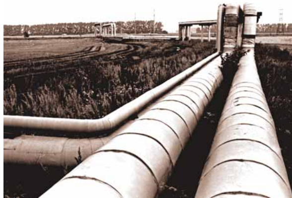
Магистральная теплотрасса. В жилых кварталах трубы уйдут под землю
