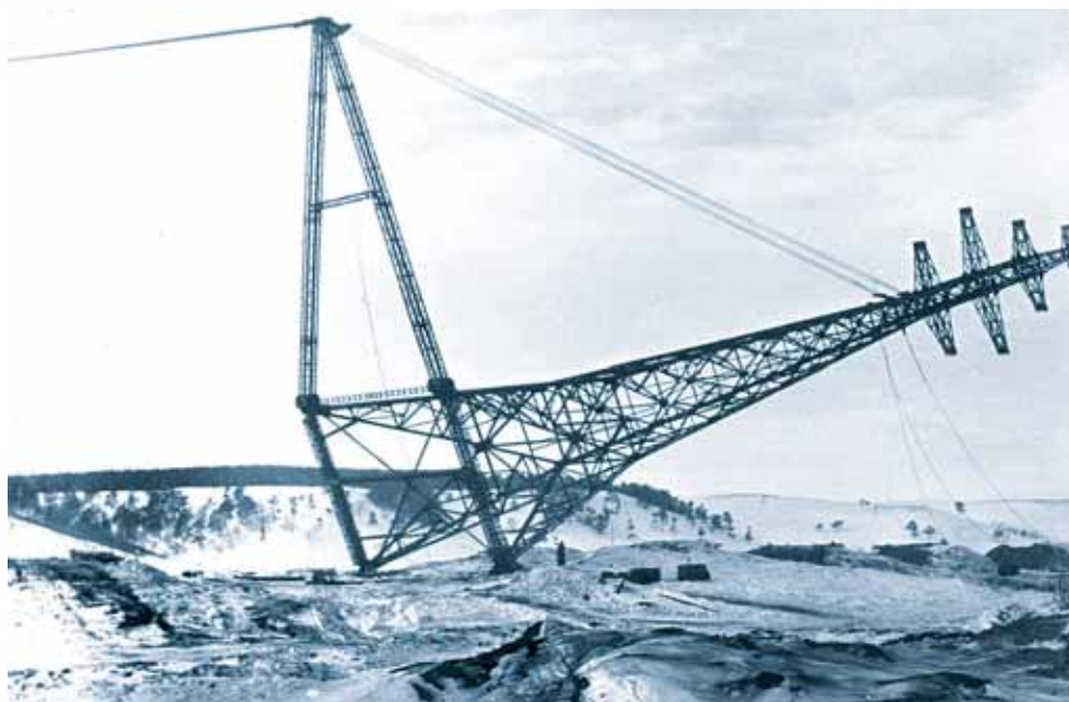
Электросетям и реки не помеха. Монтаж переходной опоры через Белую, 1964 г.
