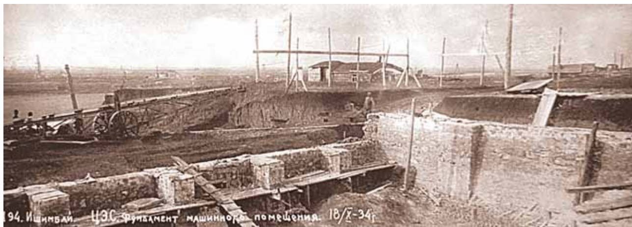
Строительство Ишимбайской ЦЭС – энергетического сердца нефтяного края
