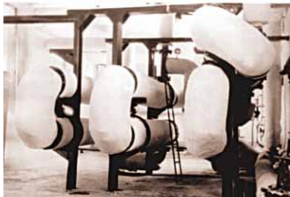
Подогреватель горячего водоснабжения – звено между ТЭЦ и потребителями
