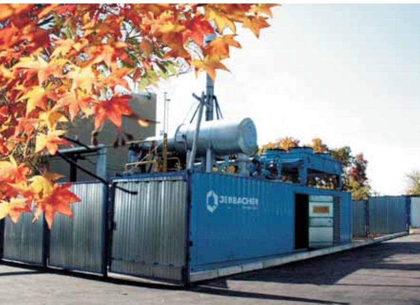
Газопоршневая ТЭЦ в санатории «Юматово»
