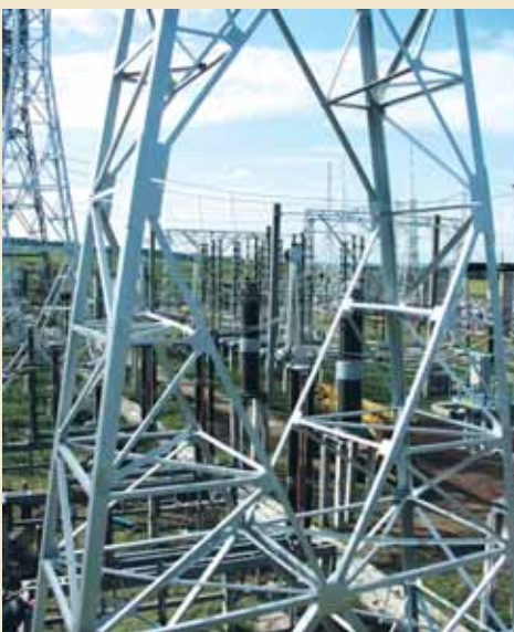
ПС «Бекетово» стала надежным энергетическим щитом столицы Башкортостана
