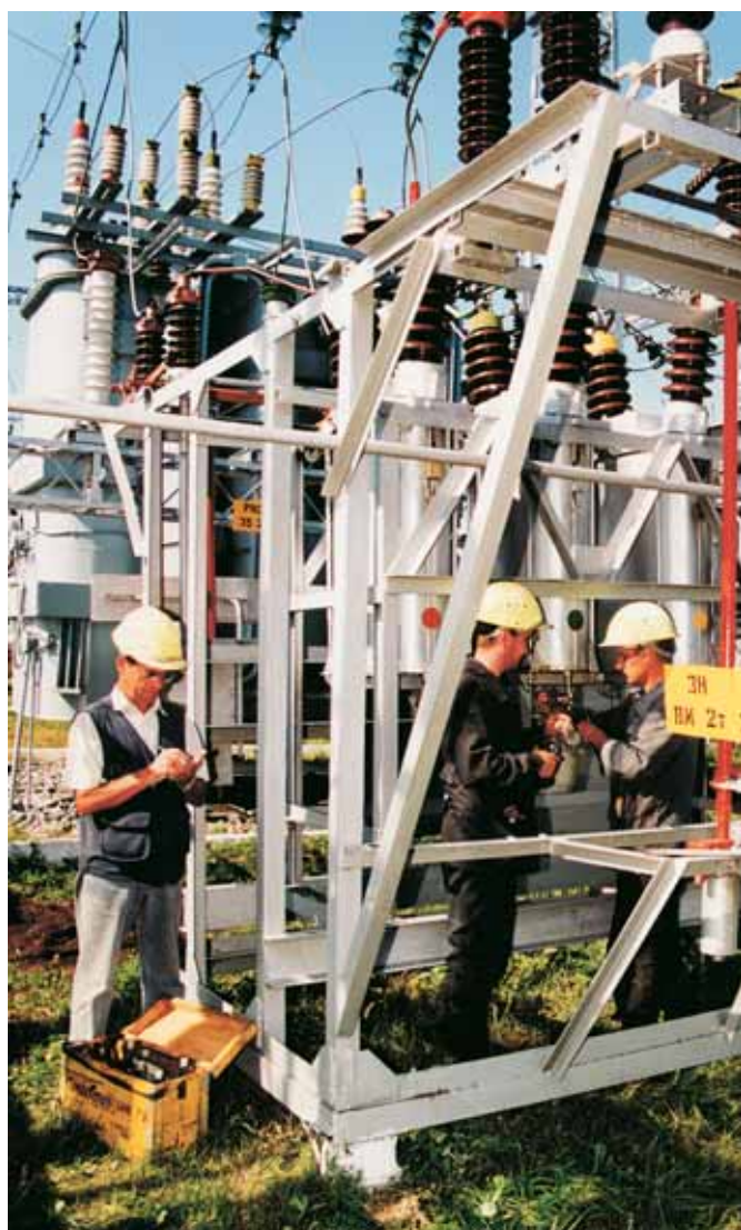
Постоянный контроль – залог надежности работы подстанций
