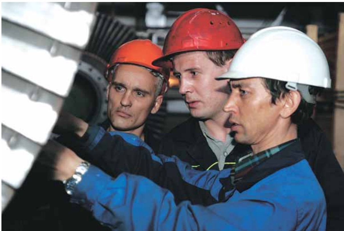
Слева направо: слесарь 6 разряда Станислав Степанов, старший мастер Артем Ананьев, старший мастер турбокотельного цеха ООО «Энергоремонт» Владимир Порубов
