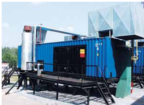
Газопоршневая ТЭЦ в санатории «Янган-Тау»
