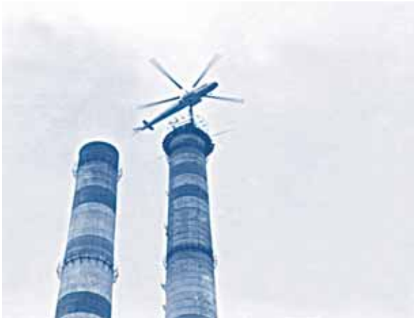
Трубы флагмана энергетики взметнулись так высоко, что для их монтажа потребовались вертолеты
