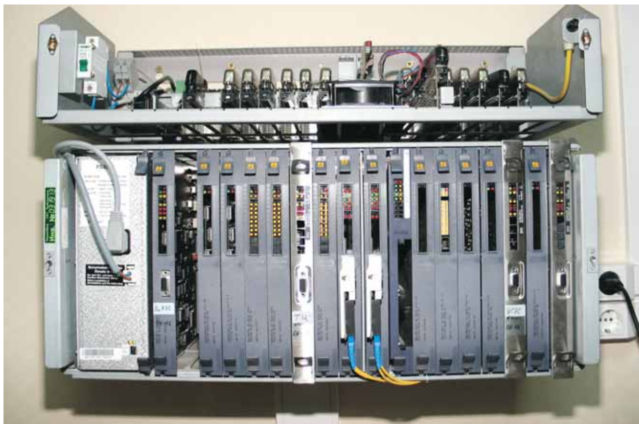
Цифровая АТС «Интеграл 33xE» емкостью 300 номеров. Вынесенный модуль центральной АТС используется как диспетчерский коммутатор
