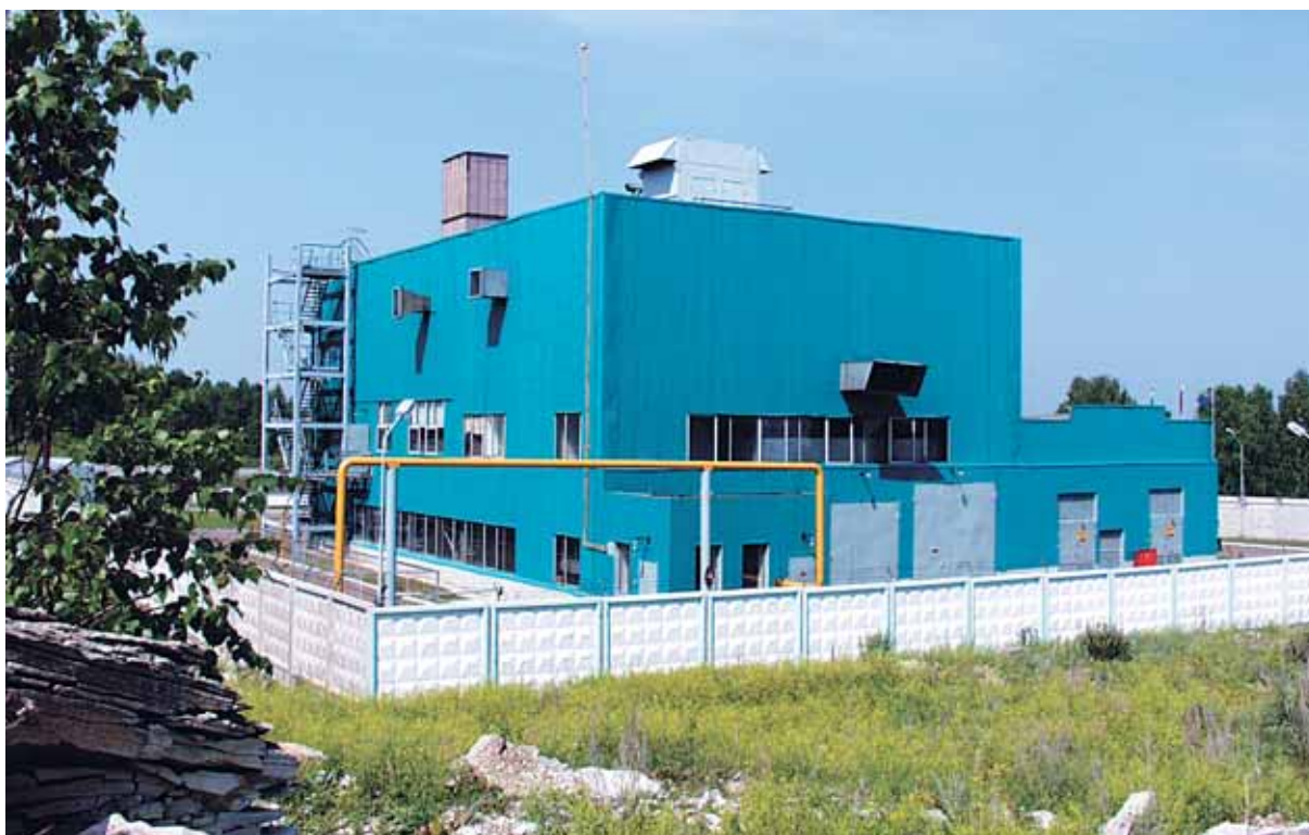
Высокотехнологичные ГТУ-ТЭЦ обеспечивают теплоснабжение потребителей на основе использования тепла отработанных газов. ГТУ-ТЭЦ «Шигили»
