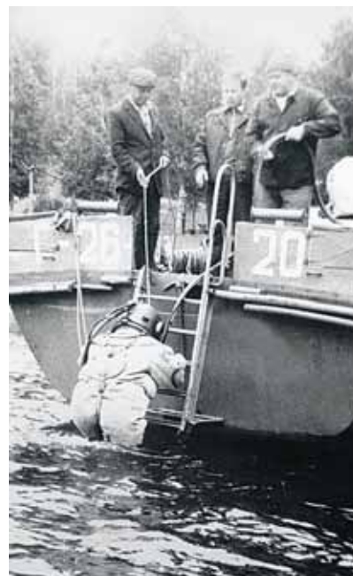
С появлением мощной ГЭС в Башкирэнерго родилась новая профессия – водолаз
