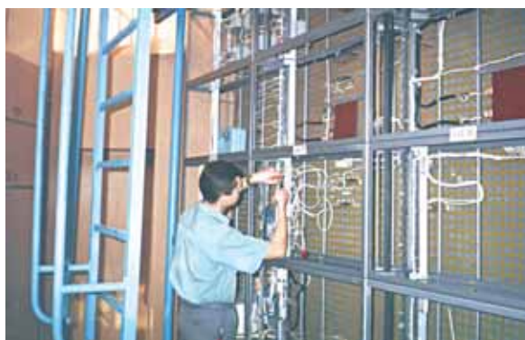
Начальник службы сбора и передачи информации А.А. Апеев проверяет правильность выполнения монтажа
