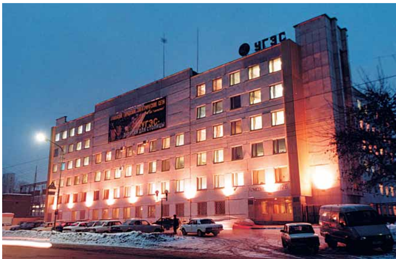
Административное здание «БашРЭС-УГЭС» ООО «БашРЭС»
