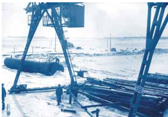
Сборка деревянных опор на пропиточном полигоне
