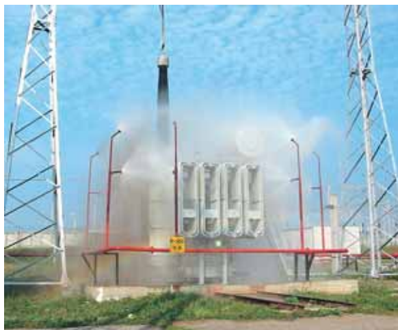
ПС «Уфимская». Опробование системы пожаротушения с поливом реактора 500 кВ
