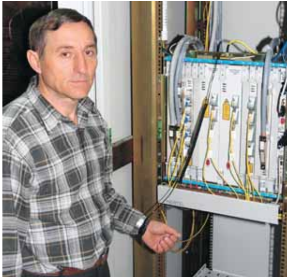
Мультиплексор уровня STM-16 синхронной цифровой иерархии выполняет функции приема, передачи, транзита до 1000 цифровых потоков 2 Мб в каждом из 8 направлений. Начальник службы телекоммуникаций В.Г. Шатов производит переключение оптических направлений
