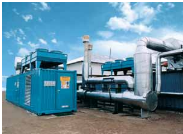
Газопоршневая ТЭЦ в санатории «Красноусольск»
