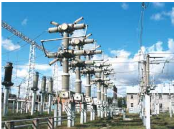
Выключатели 220 кВ вчера...
