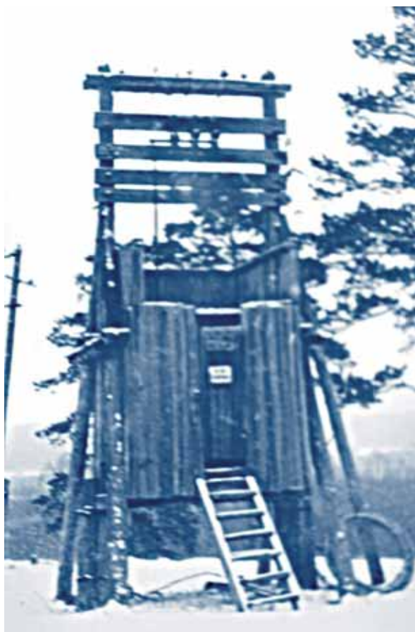
Одна из первых трансформаторных подстанций
