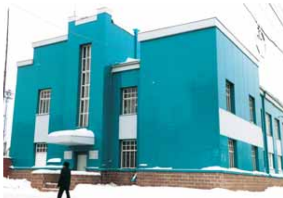
Старейшая подстанция республики (ГПП-1) была пущена в эксплуатацию в 1929 году
