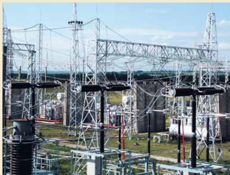
Вопросы транспортировки и монтажа оборудования уникальной подстанции требовали неординарных решений
