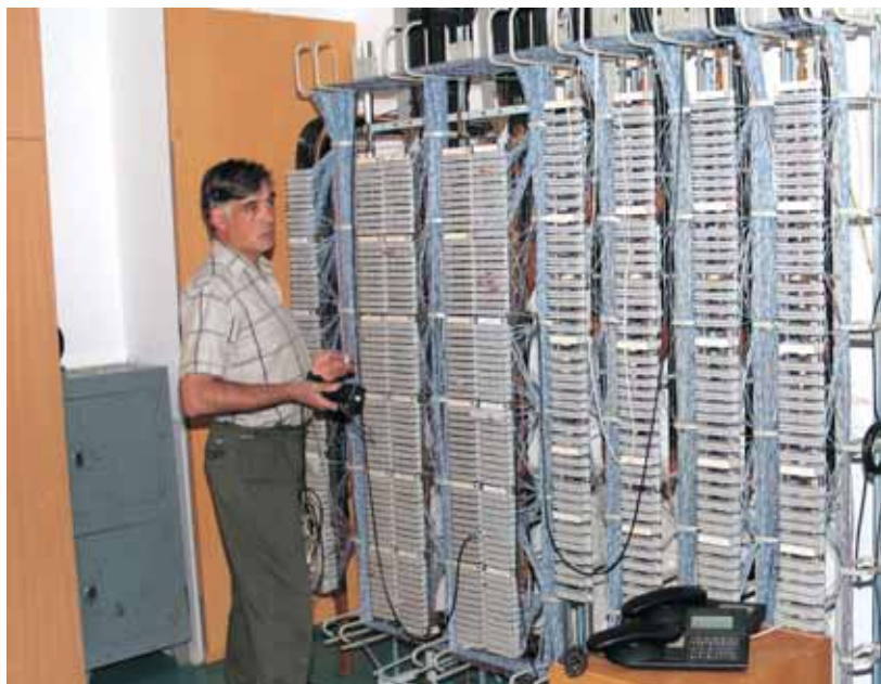
Кросс центрального узла связи на 3000 линий связи. Электромонтер Ю.Н. Федорук проводит измерения линий связи
