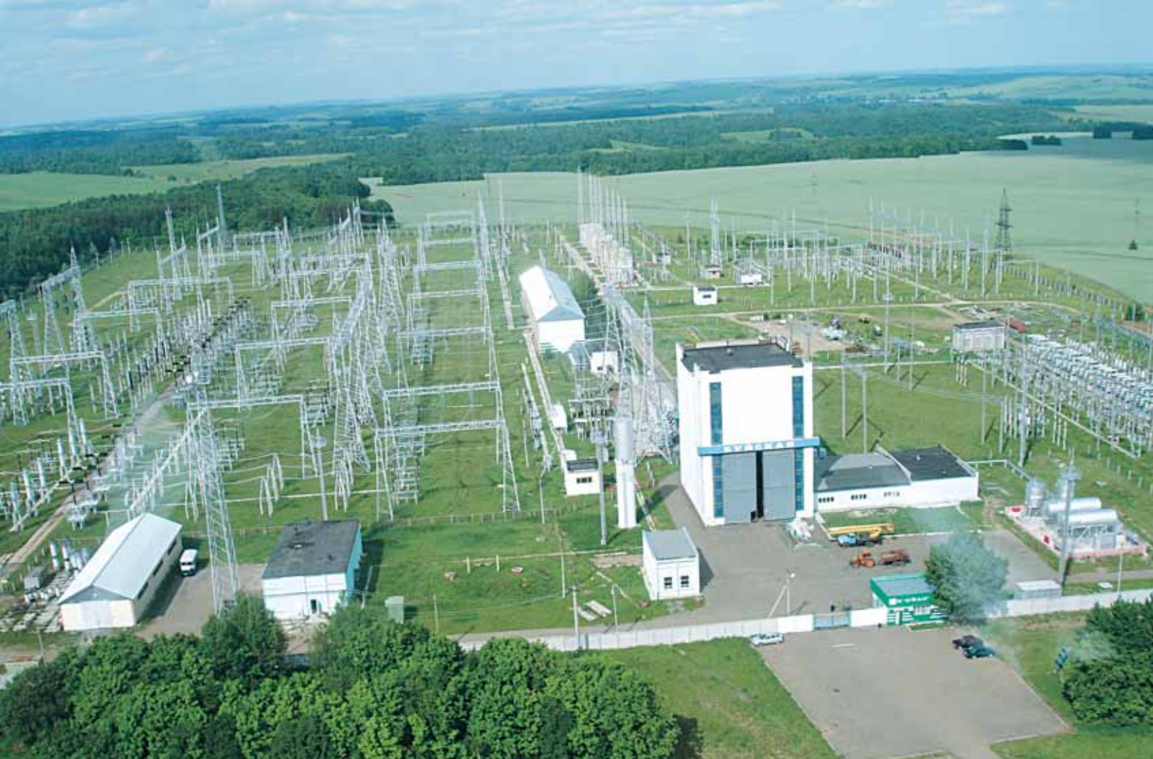
ВЛ «Буйская - Уфимская» (справа) через подстанции «Буйская» (вверху) и «Уфимская» (внизу) соединила Кармановскую ГРЭС с уфимским промышленным узлом. Высоковольтная линия и подстанция «Уфимская» введены в эксплуатацию в 2000 году
