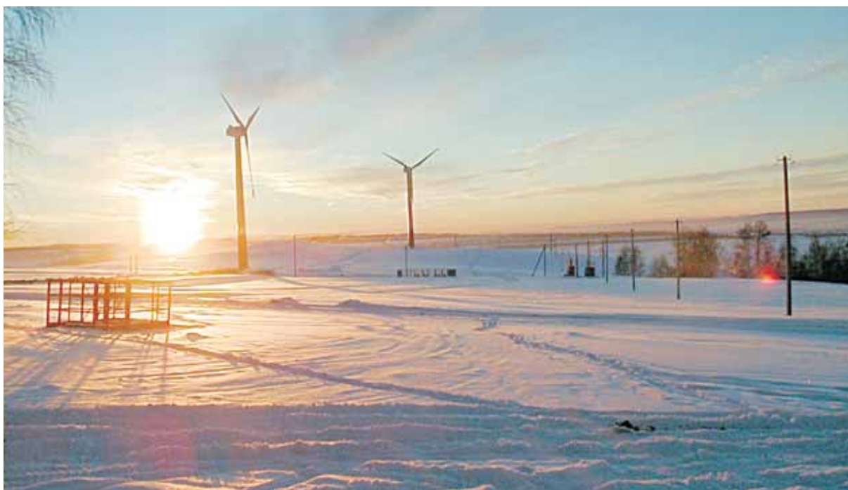
Будущее энергетики – за новыми технологиями. Ветровые установки вблизи деревни Тюпкильды
