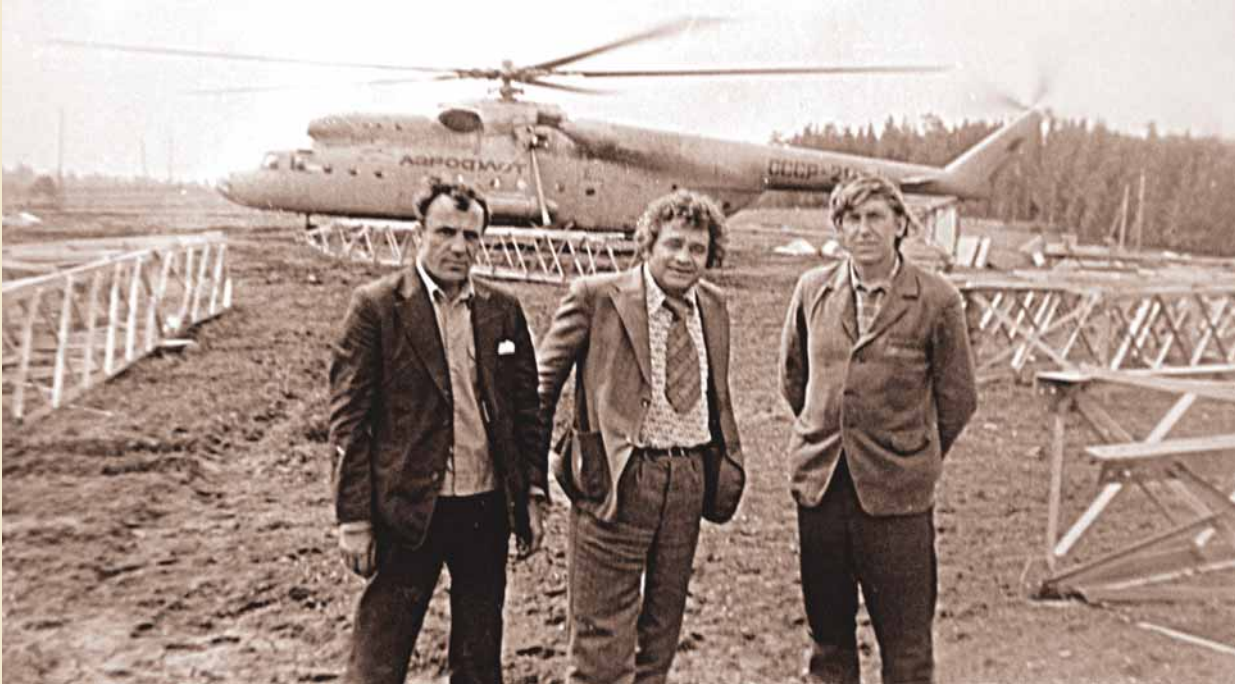
ПС «Бекетово», начало строительства. Пришлось облететь все окрестности столицы
