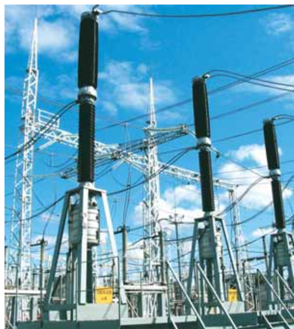
...элегазовые выключатели 220 кВ сегодня
