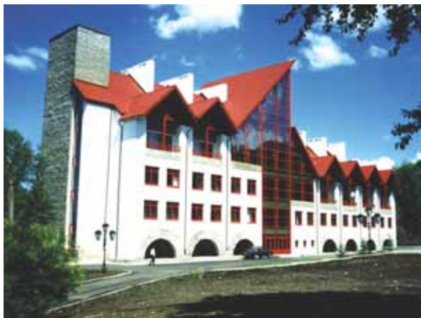
Корпус санатория «Красноуольск» после реконструкции
