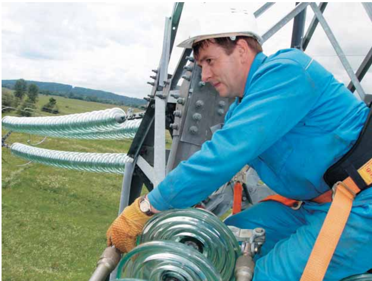
Замену дефектных изоляторов на ЛЭП-500 кВ выполняет Андрей Анатольевич Струговец
