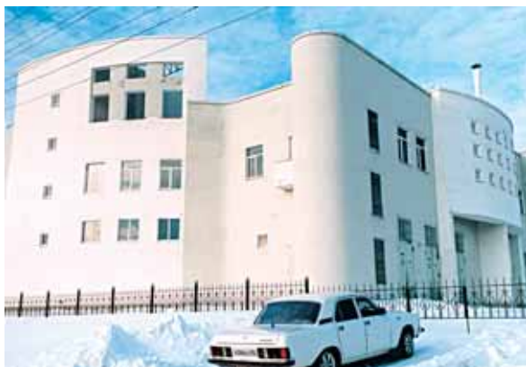
ПС «Дружба» построена в 2000 году
