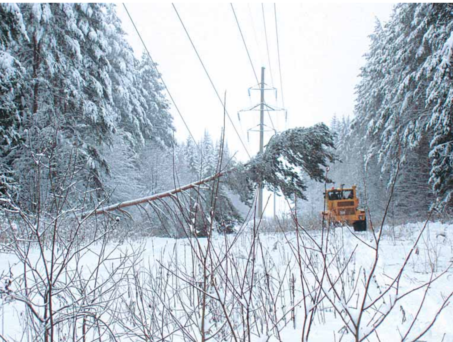
Опыт и оперативность персонала, а также современная техника помогают предотвратить тяжелые последствия гололеда на линии электропередачи...
