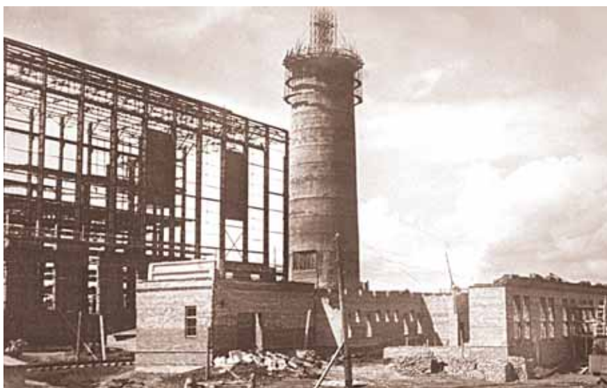
Строительство Кумертауской ТЭЦ
